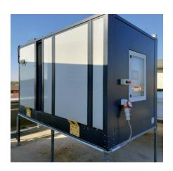
Funzionamento a secco: l'aria esterna viene aspirata e convogliata sulla batteria alettata. Il processo di umidificazione è disattivato, non c'è presenza di acqua e la sezione adiabatica è asciutta.
