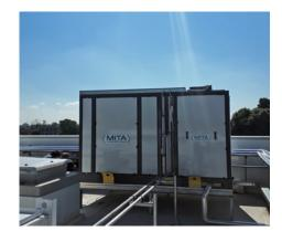
Le sonde di temperatura presenti modulano la velocità del ventilatore e i cicli di bagnatura (cicli adiabatici) per ridurre al minimo l'utilizzo di energia/acqua.
