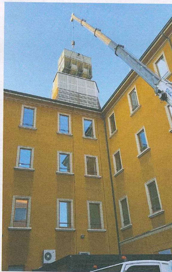
RIMOZIONE della vecchia torre evaporativa
